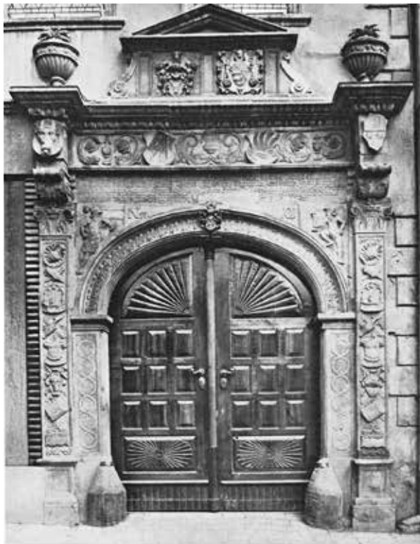
Původní zámecký portál Jana Bohatého, po přestavbě zámku druhotně osazený v domě sekretáře Mikuláše Onše z Břesovic, dnes Prostějov, náměstí T. G. Masaryka 24; pískovec, před r. 1532. Foto: archiv autorky.
