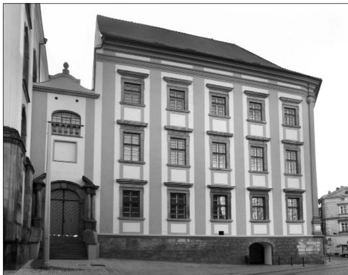
Budova po rekonstrukci v roce 2008 (Foto: P. Rozsívál)
