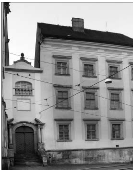
Budova depozitářů před rekonstrukcí v roce 2005 (Foto: P. Rozsívál)
