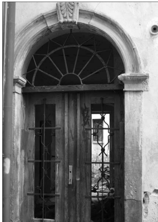
Vstup do tajemna..., foto: M. Dokoupilová.
