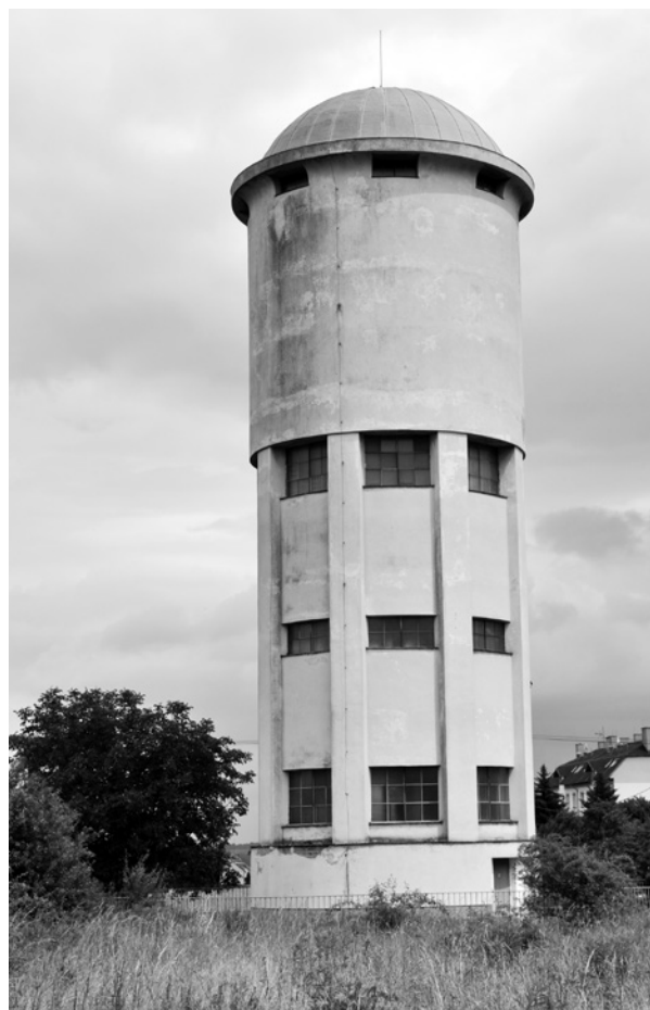
Věžový vodojem Kourim, 2015. Foto: R. Korínek.
