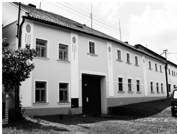
Senička, č. p. 25. Bývalá zemědělská usedlost ve Vesnické památkové zóně Senička po rekonstrukci.
