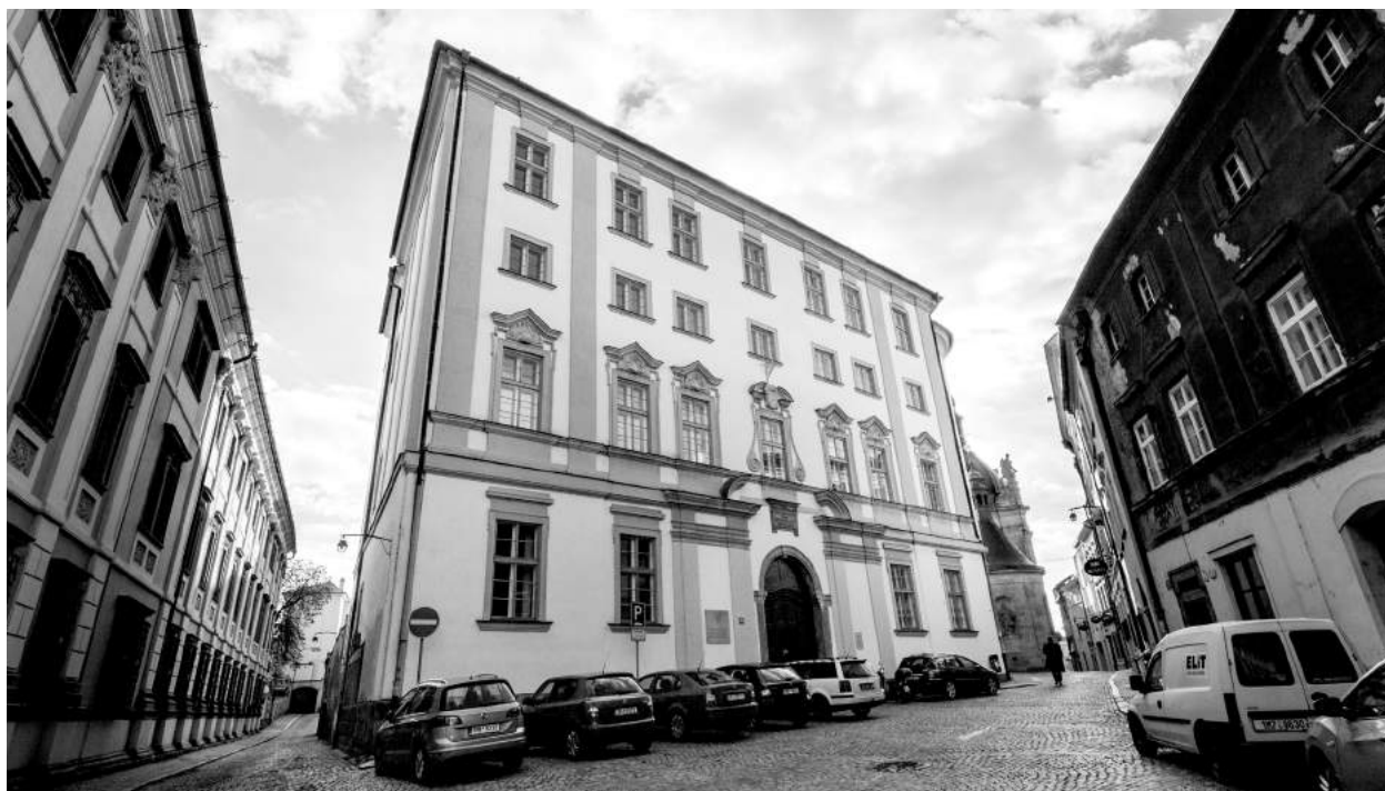
Dnešní stav budovy Cyrilometodějské teologické fakulty Univerzity Palackého v Olomouci, Univerzitní ul. č. 22. Foto: Jakub Hutýra (2015).
