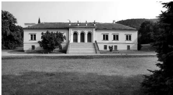
Zámek – prostor schodiště. Foto: archiv VKOL.
