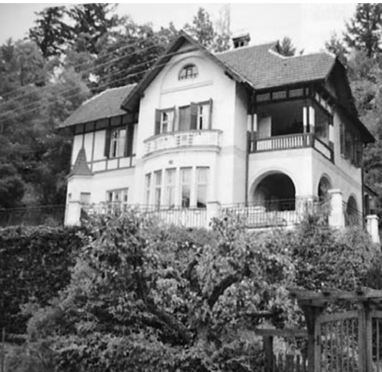
Rodinná vila Wichterlových na Stražisku (stavba z let 1910–1911). Foto: Muzeum a galerie v Prostějově.
