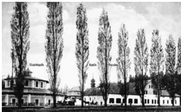
Pohled na lázeňské budovy losinských lázní ze severní strany, přelom 19. a 20. století.
